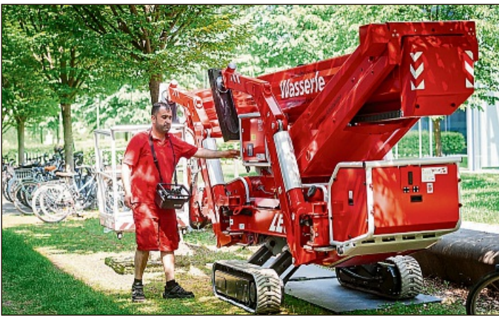
Hier ist eine Hebebühne zur Fassadenreinigung aus dem eigenen Fuhrpark von Wasserle im Einsatz.
